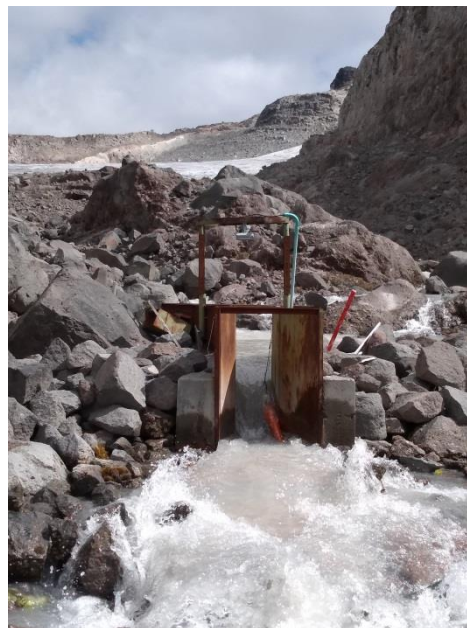
Fotografía 19. Estación hidrológica “Conejeras 2” ( canaleta Parshall)
