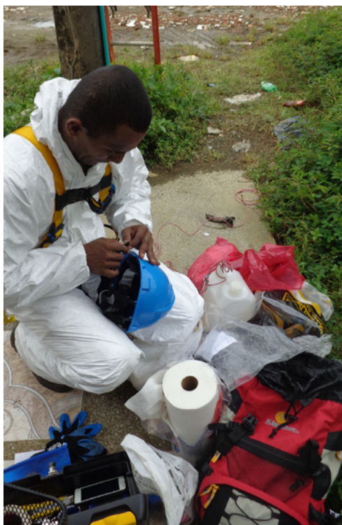
◀ Alistamiento de insumos para mantenimiento en campo de equipos eléctricos.
