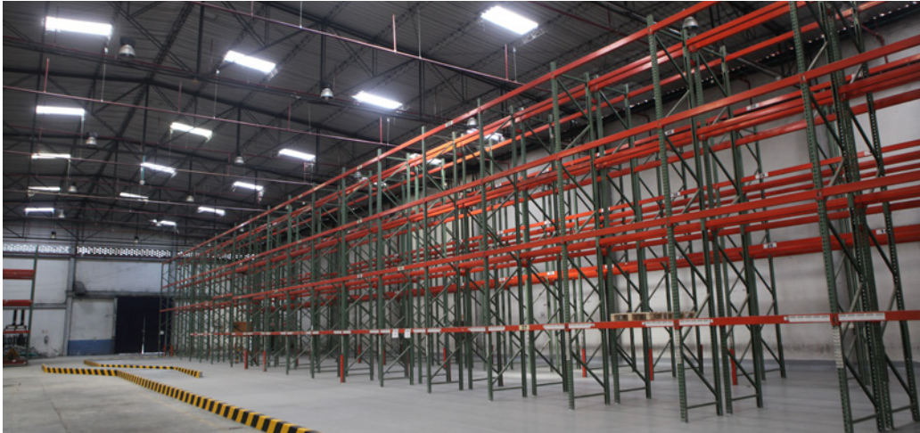
◀ Área de almacenamiento de equipos y/o desechos contaminados con PCB
