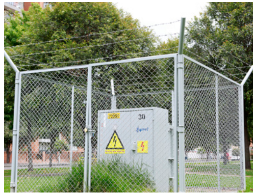
◀ Transformador tipo pedestal ubicado en zona pública
