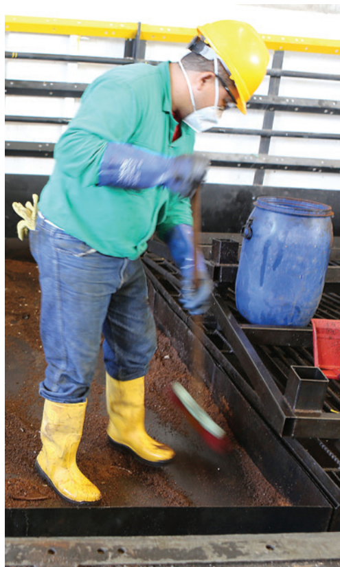
◀ Recolección de material absorbente contaminado con aceites dieléctricos
