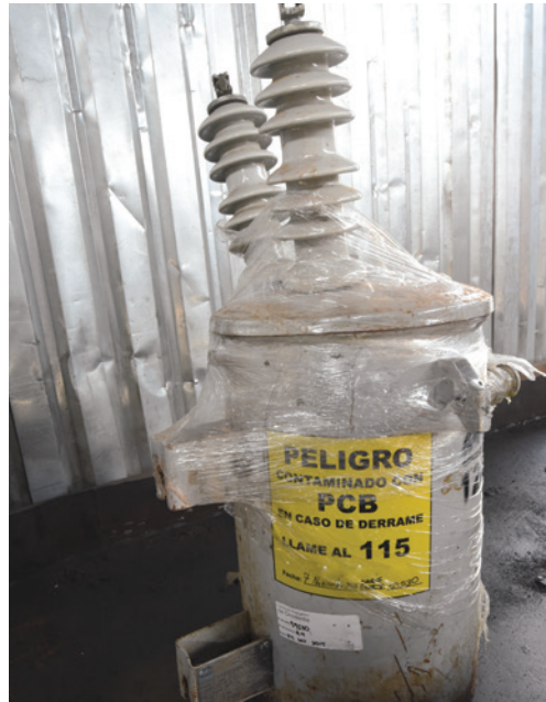
◀ Equipo contaminado con PCB
